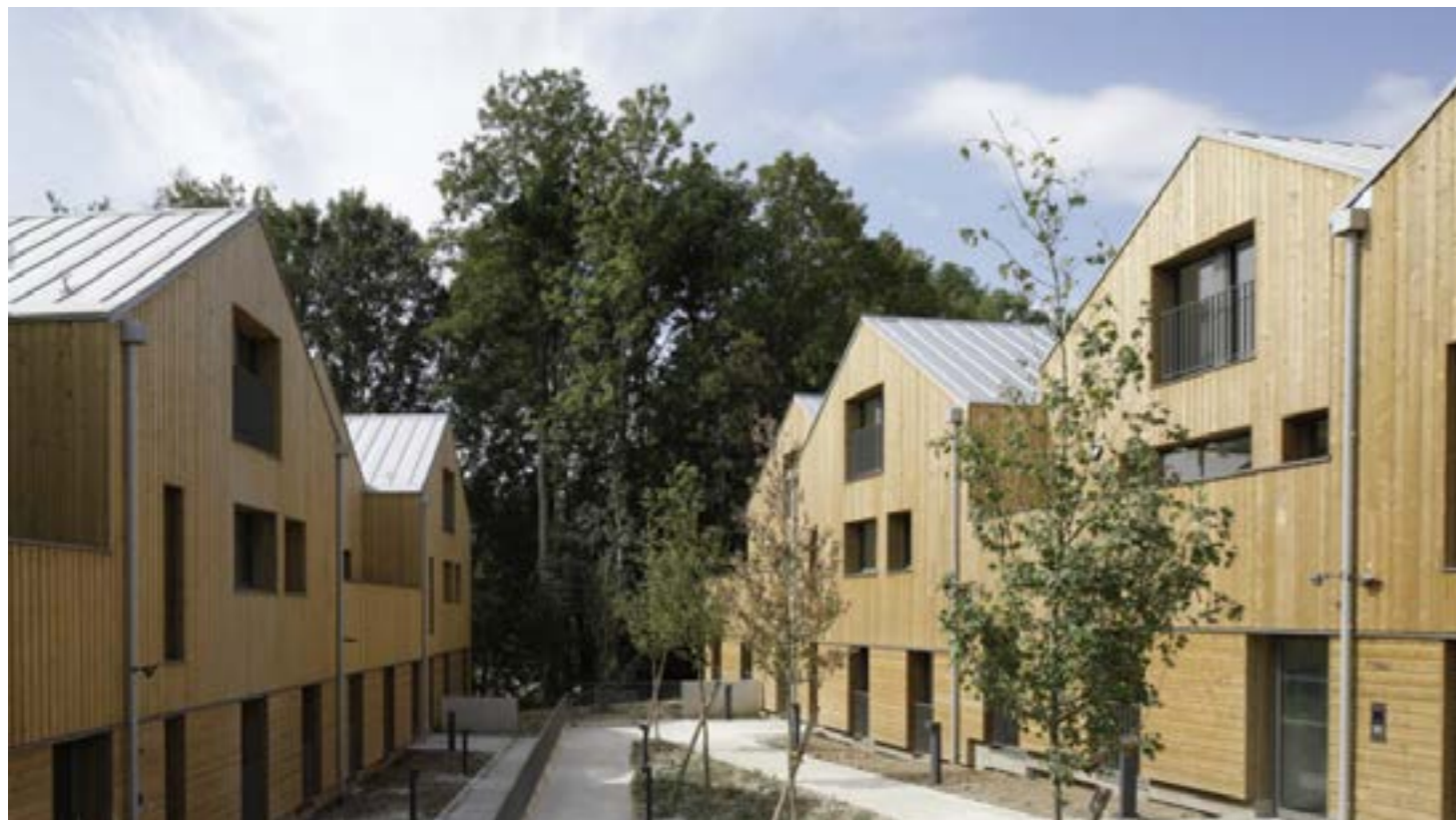
Atelier Mosca, Saint-Rémy-lès-Chevreuses
